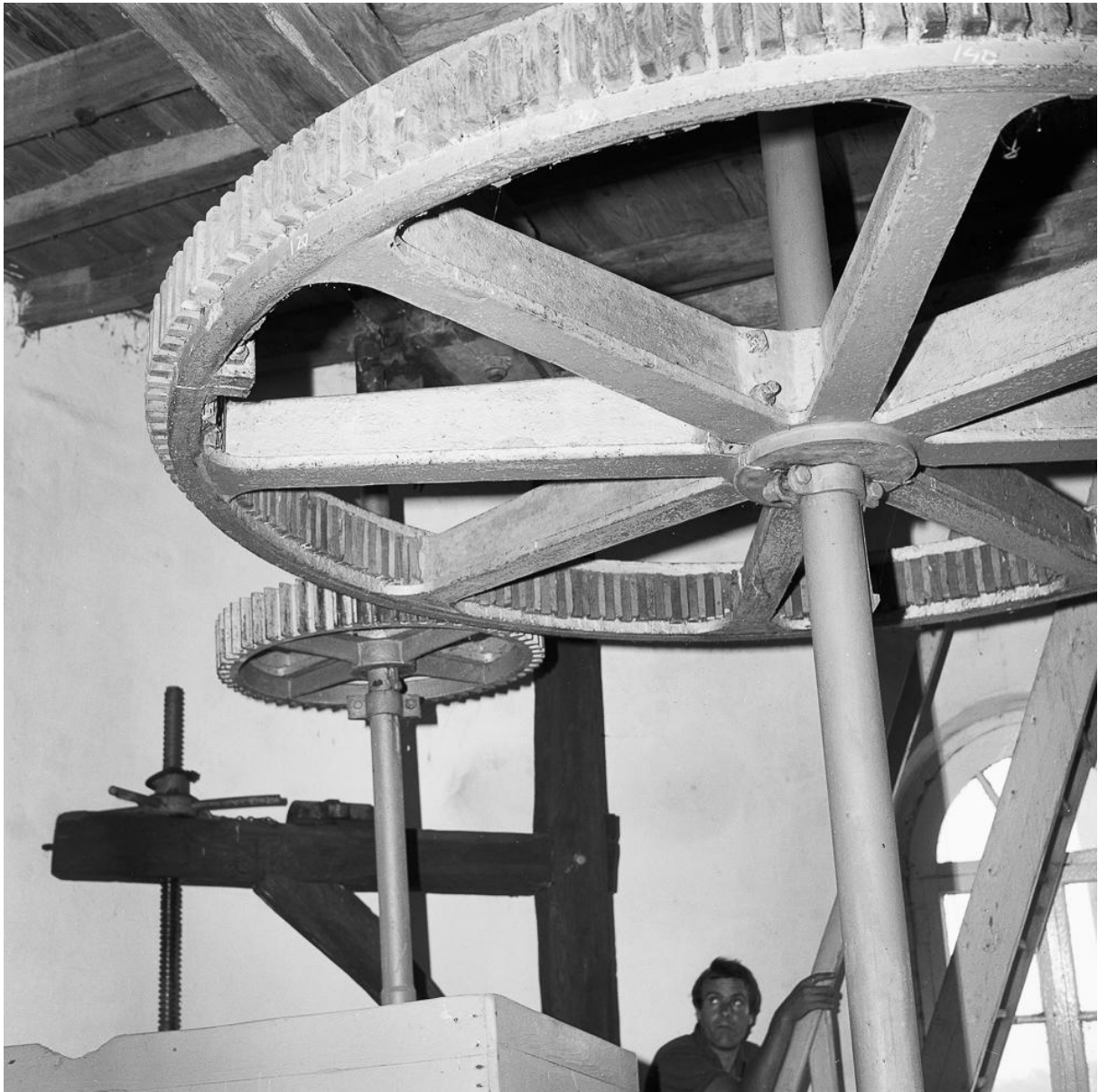
Het gietijzeren binnenwerk van de Sint Antoniusmolen in Laar in 1984, afkomstig uit de Van Tienhovenmolen in Wolfshuis. Foto: Rijksdienst voor het Cultureel Erfgoed, Amersfoort / 252787
